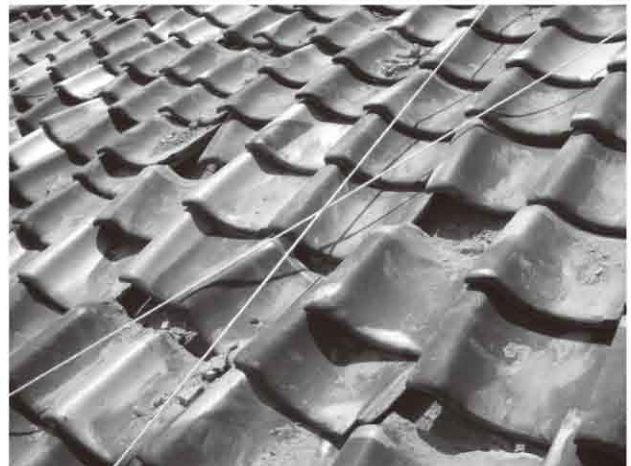
塩害を受け、地震の揺れで引掛けの剣がとれてしまった瓦
