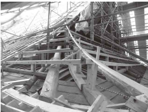
北西隅小屋組補修の様子
