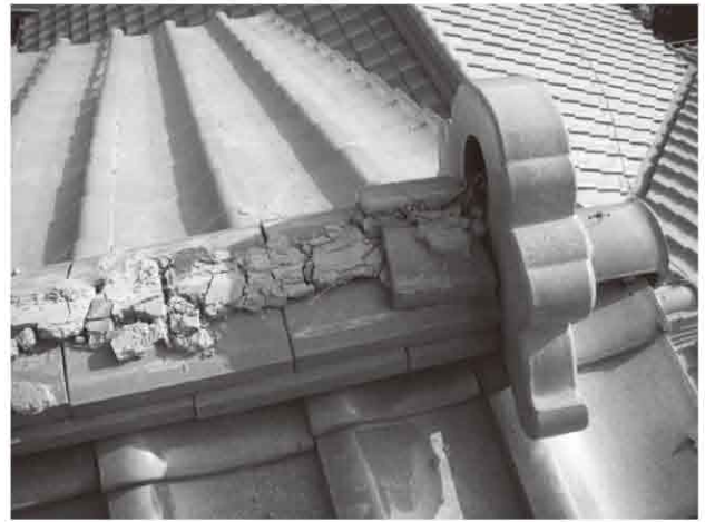
4. 瓦を保持する力に欠ける屋根土を棟内部に使用
