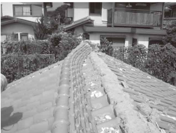
3. 内部の屋根土の風化
