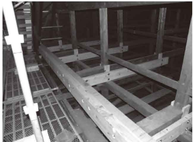
新規前包みと補強の様子
