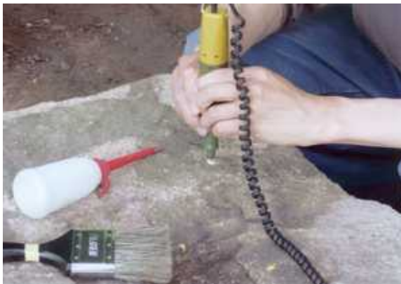
2. 内部剥離部分、小穴から接着用樹脂(2)流し込み
