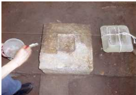
4. 礎石も含浸補強
