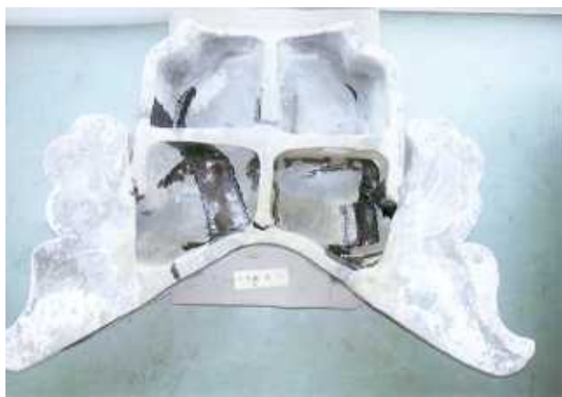
3.裏面接着部分の補強
