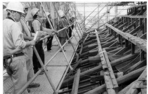
大日本報徳社大講堂修理現場見学
