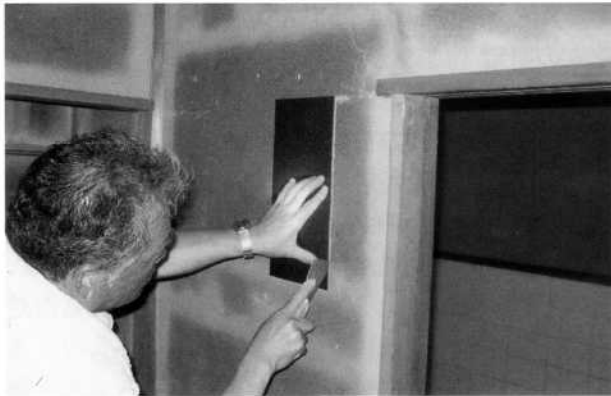
楽寿館内土壁調査（両角会員）
